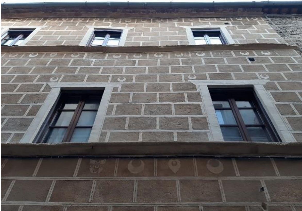
Particolare della facciata ad intervento ultimato
