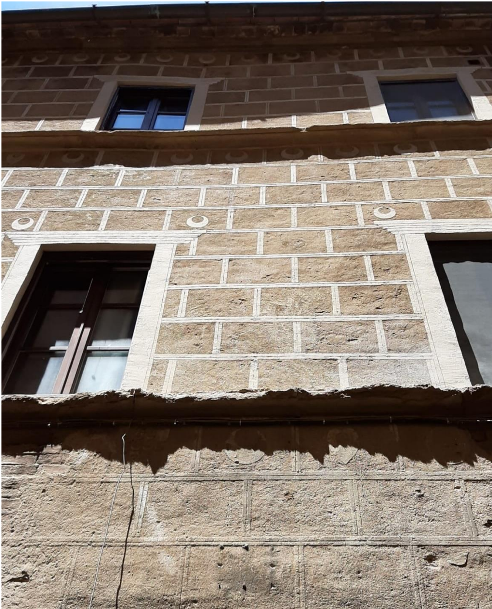
La facciata come appariva al termine della prima fase dei lavori di restauro (giugno 2021)
